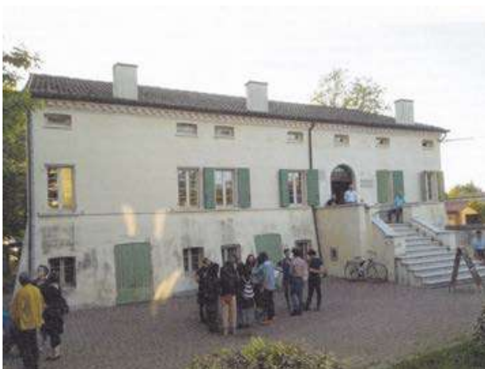
Figg. 75-76) - Stellata Casa Ariosto, prima e dopo il restauro.
